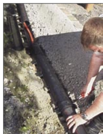
click-fix über bestehendes Rohr legen
