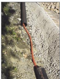
click-fix über bestehendes Rohr legen
